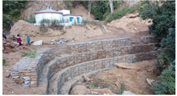
टेवा पर्खाल निर्माण, रिब्दीकोट, पाल्पा
