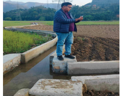
सिचाईकुलो निर्माण (१७५ मि.), तानसेन
